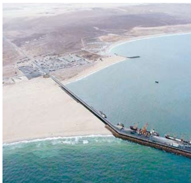
Les infrastructures portuaires sont à l'origine d'importantes modifications de l'évolution du trait de côte. Le port de Nouakchott : accrétion au Nord, érosion au Sud.
