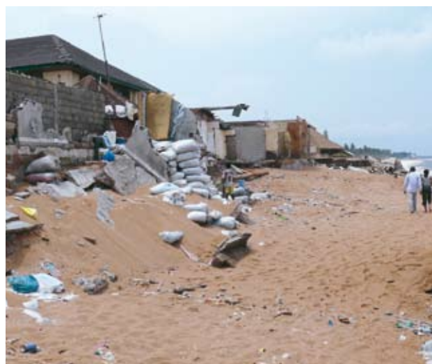
Effondrement d'habitations et tentatives de protection individuelle.
